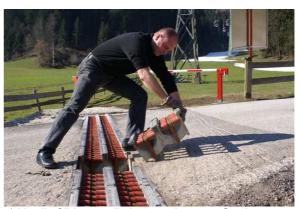
4) Nordic Slider um die Längsachse 180 Grad drehen.
