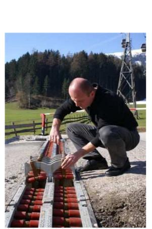
Rollenelemente in horizontaler Position fixieren. Max. Drehmoment 25 Nm.
